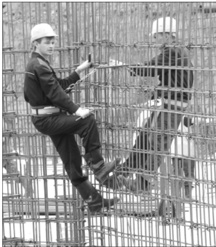
На спортивной стройке кипит работа.
