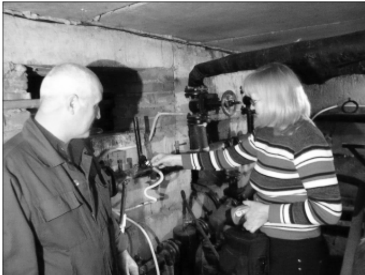
Приемку инженерных сетей в доме № 1 по ул. Комсомольской ведет ведущий специалист ООО «ГК Нытва-Энерго» Александра Безматерных. Претензий нет.
