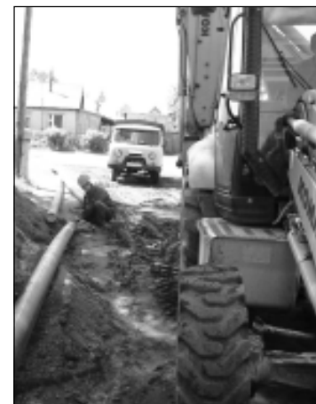
Завершаются подготовительные работы по прокладке газовой магистрали в левобережье Нытвы.
