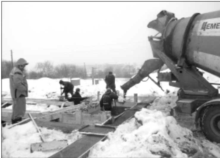
Полным ходом идет заливка фундаментов на одном из объектов будущих очистных сооружений.
